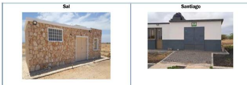
Figura 4-1: Áreas de armazenamento de resíduos dos parques eólicos do Sal e de Santiago
