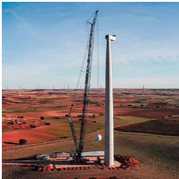
Figura 2-25 Instalação de um rotor eólico com guias especiais utilizando uma almofada de grua
