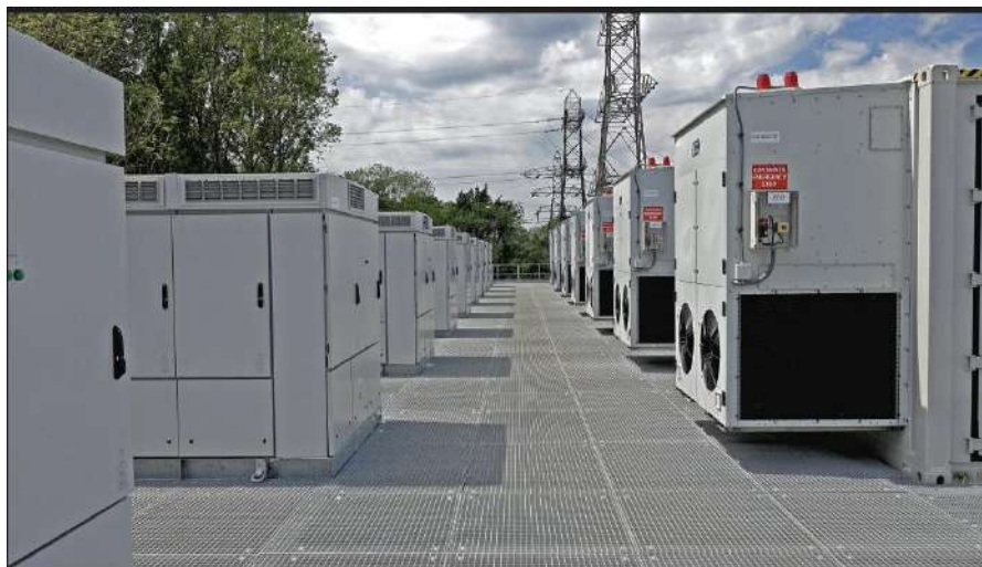
Figura 2-6 Configuração típica de BESS
