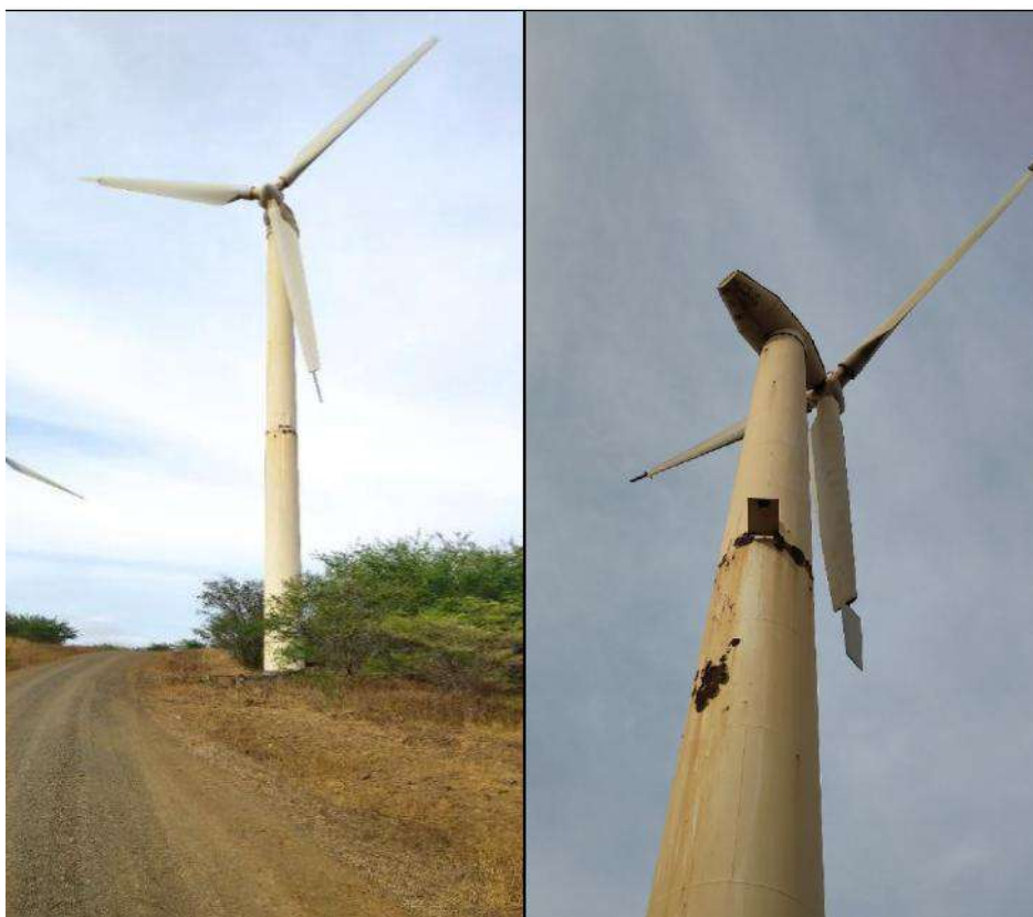
Relatório de visita ao local da Tractabel, novembro de
