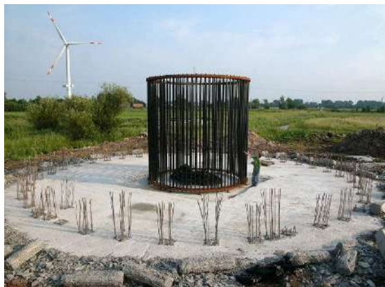
Figura 2-26 Exemplo de fundação de turbina eólica
